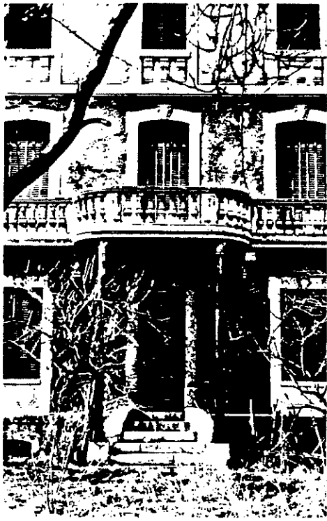
entrée sur jardin - perron protégé par un balcon en ciment tenu par deux colonnes en fonte
