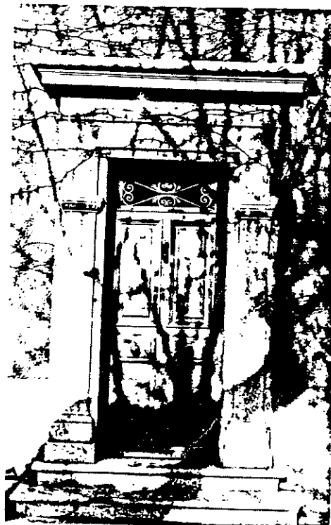
soubassement en pierres taillées (granite rose de Guillestre) murs en maçonnerie de pierres, enduits au ciment pourtour des fenêtres en éléments de ciment moulé pourtour des portes et seuils d'entrée en pierres taillées surélévation au niveau de rez-de-chaussée
