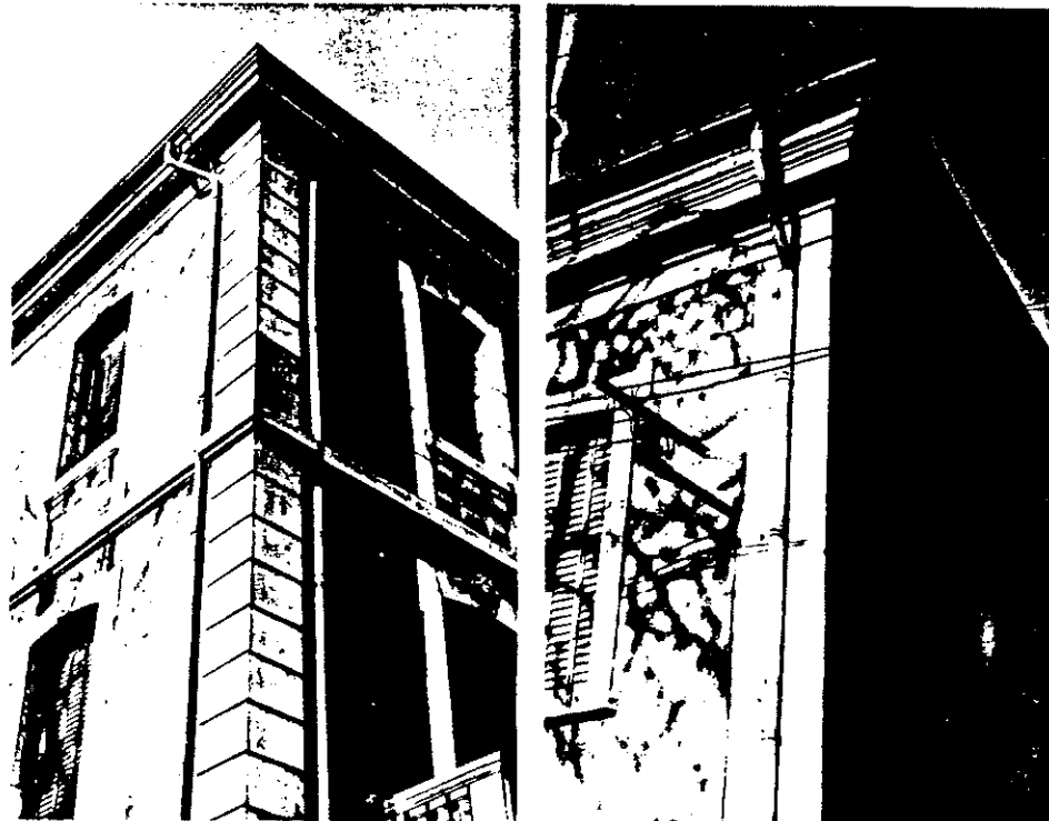
angle renforcé simulant une colonne et dépassée de toiture fermée par une corniche : référence au classicisme et emploi du ciment moulé.
