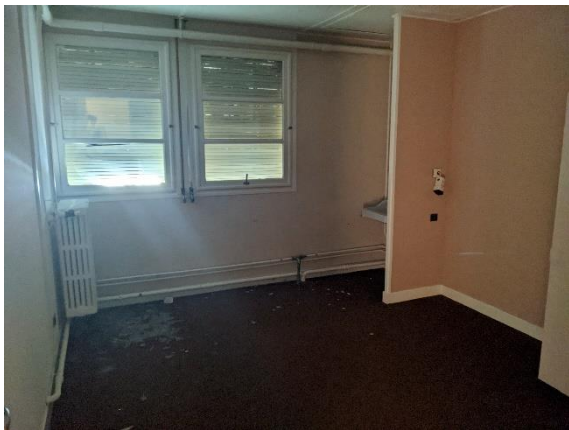
Exemple de pièce dans la bâtiment n°6
