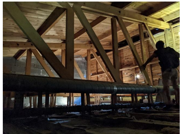
Combles du bâtiment n°6
