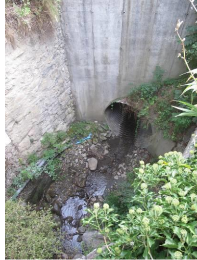
Ouvrage de franchissement de la RD (buse), vue de l'amont
