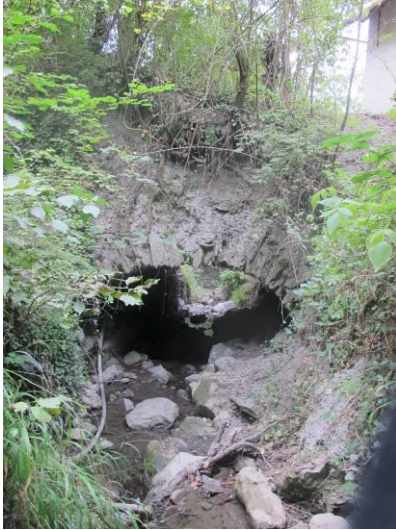
Torrent de Charance, à proximité de la RD 466. Deux ouvrages couvrant le torrent Voute en pierre, en amont de la RD
