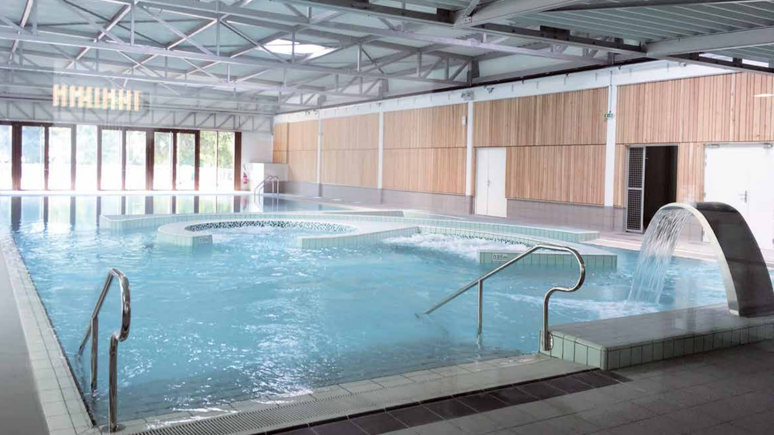
Le centre aquatique intercommunal AQUAVIVA.
